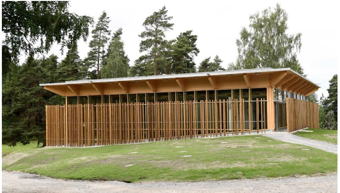
Hegnhuset er læringscenteret på Utøya, og er blant annet kalt et av verdens viktigste undervisningsbygg. Arkitekt: Erlend Blakstad Haffner, Foto: Jon Olav Nesvold / NTB Scanpix
