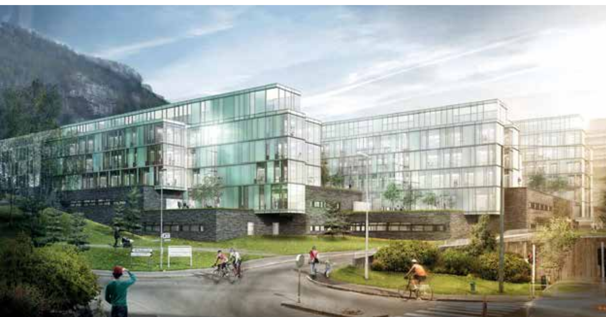
Byggetrinn 2, sett fra Haukelandsveien.
